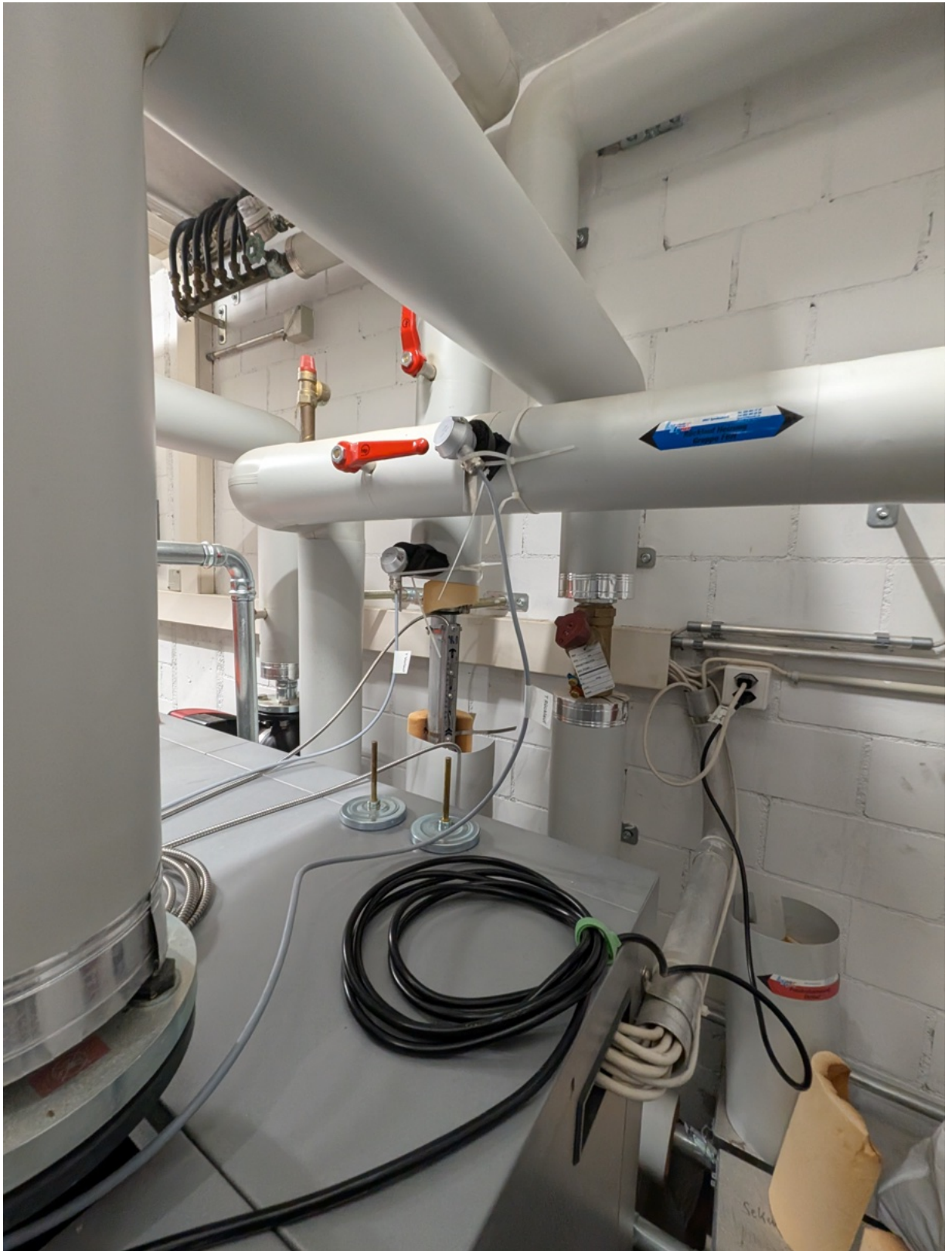
Abb. 2: Messaufbau der Wärmemessung
